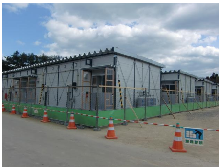
*でき始めた仮設住宅
