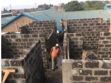
今日で2階部分の壁・柱が出来上がりました。今後は、梁・屋根の工事が始まります。
