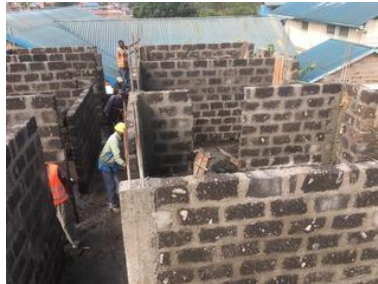
今日で2階部分の壁・柱が出来上がりました。今後は、梁・屋根の工事が始まります。
