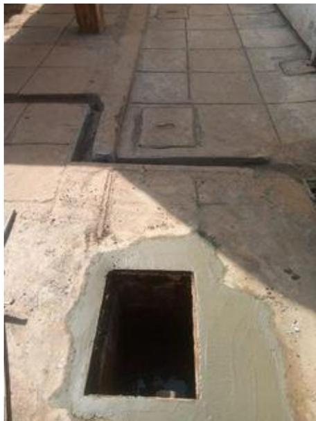
側溝と排水設備をつなぐ場所はむき出しの状態では危なかったため、コンクリートで固め、取っ手と蓋を付けました。
