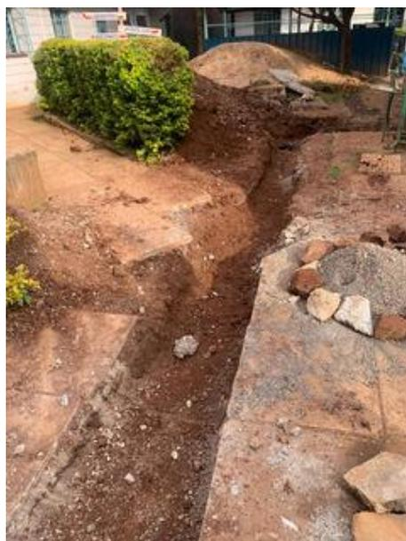
建築家の方と相談し、側溝から雨水を外に出せるようにすることはもちろん、蓋を付けて車いすの方などでも安全に通ることができるように計画しています。コロナ禍ですので、安全第一で工事が完了できるようにしたいです。
